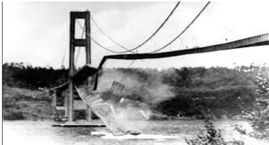
شکل ۱-۲ پل تاکومار بعد تخریب [۱].
