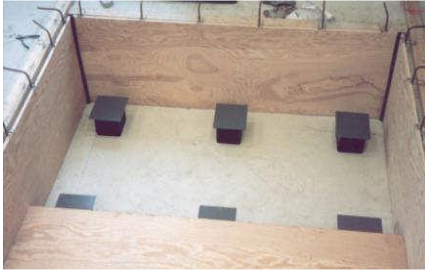
شکل ۱-۴ پدهای پلاستیکی نصب شده بر ساختمان [۳]
