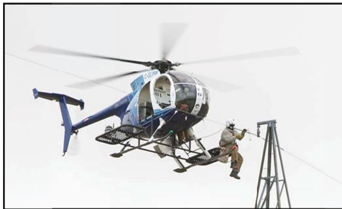
شکل (۳-۱) بازرسی از خطوط انتقال فشار قوی با استفاده از بالگرد
