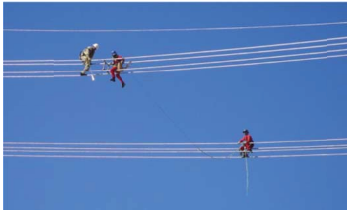
شکل (۲-۱) بازرسی خطوط انتقال فشار قوی با سوار شدن بر خط
