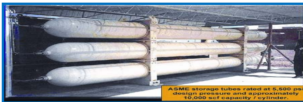
شکل (۲-۶) مخازن ترتیبی ASME
