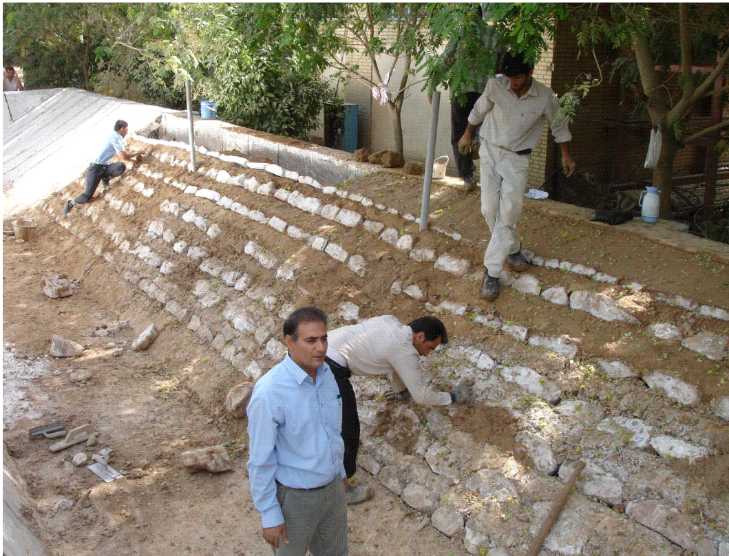
شکل (۵.۳): نمایی از مدل آزمایشگاهی (نمونه های نمک سازند کارستی در محل های مورد نظر قرار داده می شوند)
