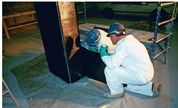
شکل ۲-۱۶: استفاده از ورق‌های FRP در تقویت ستون
