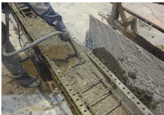
(ب) بتن‌ریزی و ویبره بتن
