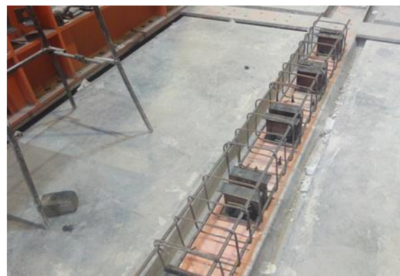
(الف) آرماتور بندی و نصب برشگیرها
