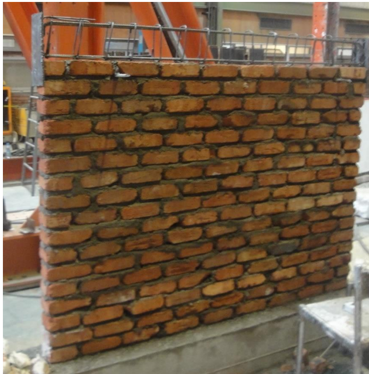
شکل ۴-۴ - ساخت دیوار و کلاف بتنی روی دیوار
