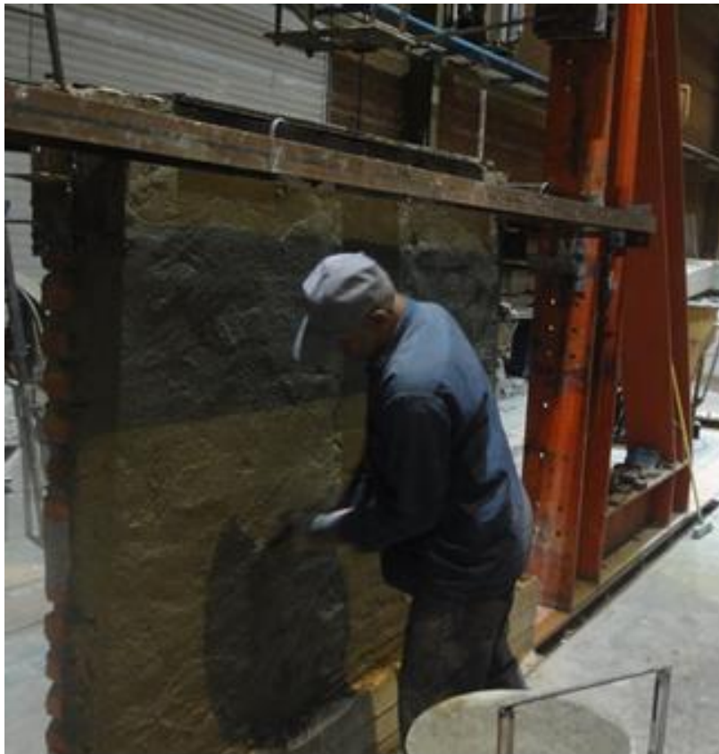
شکل ۴-۶- نحوه اجرای ملات ECC روی دیوار
