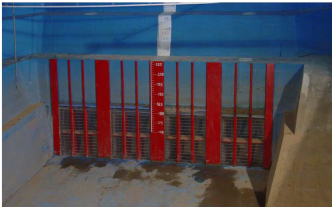
شکل ۳-۱۰- نمای ورودی آبگیرها با آشغالگیر
