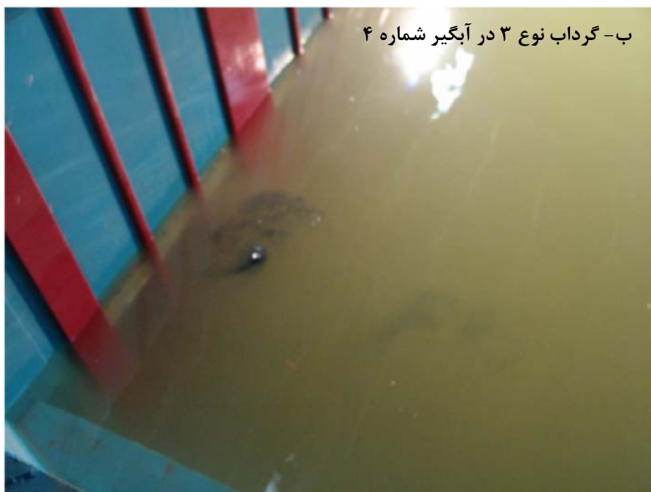
شکل ۴-۱۵- گرداب‌های تشکیل شده در بهره‌برداری همزمان از آبگیرهای ۳ و ۴ در تراز ۱۸۵
