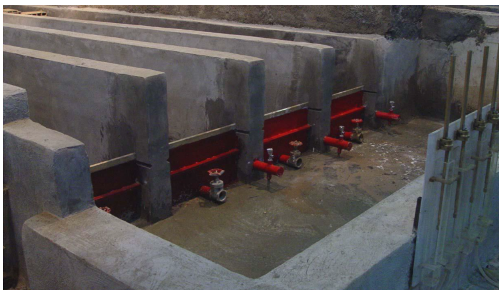
شکل ۳-۹- نمایی از سرریز مستطیلی جهت اندازه گیری دبی
