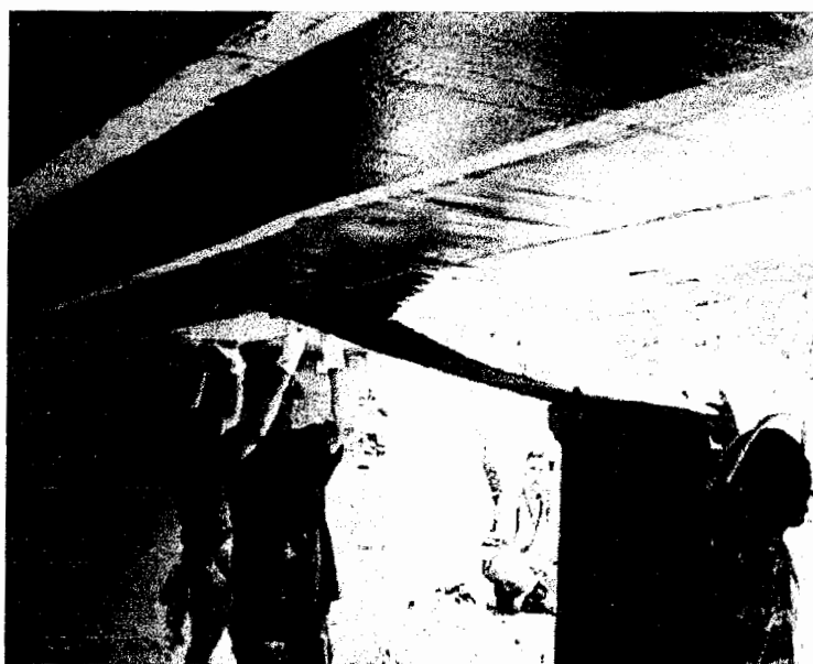
شکل ۱-۲: نحوه مقاوم سازی خمشی
