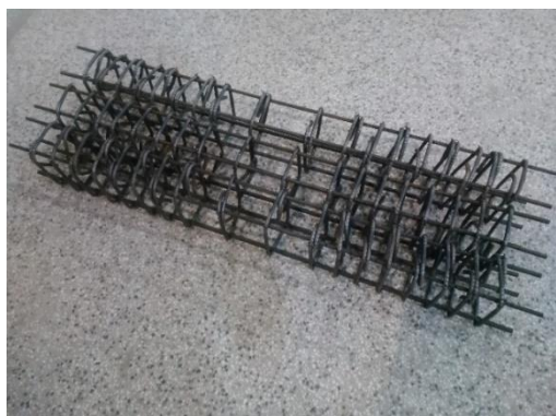
شکل ۳-۱۴: نحوه آرماتوربندی و قرارگیری آرماتورها در قالب تیر
