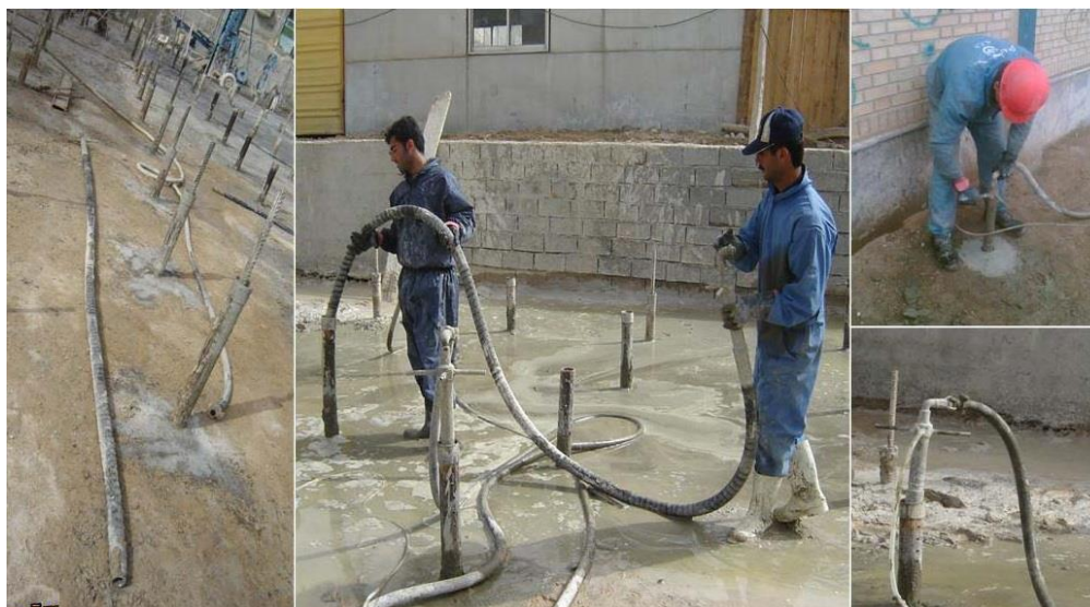
شکل ۲-۵ روند اجرای میکروپایل
