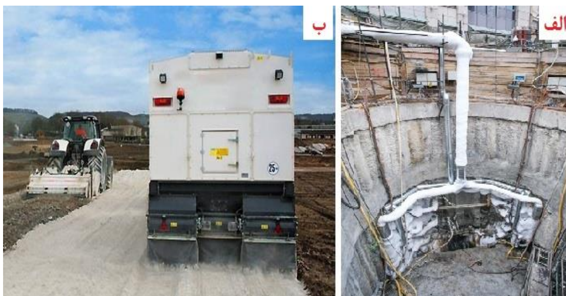
شکل ۲-۲ (الف) بهسازی فیزیکی به روش انجماد خاک و شکل (ب) بهسازی شیمیایی با آهک پاشی
