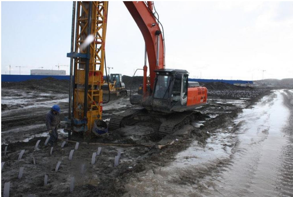
شکل ۳-۲ کارگذاری فیلترهای تخلیه‌ی آب اضافه‌ی منفذی
