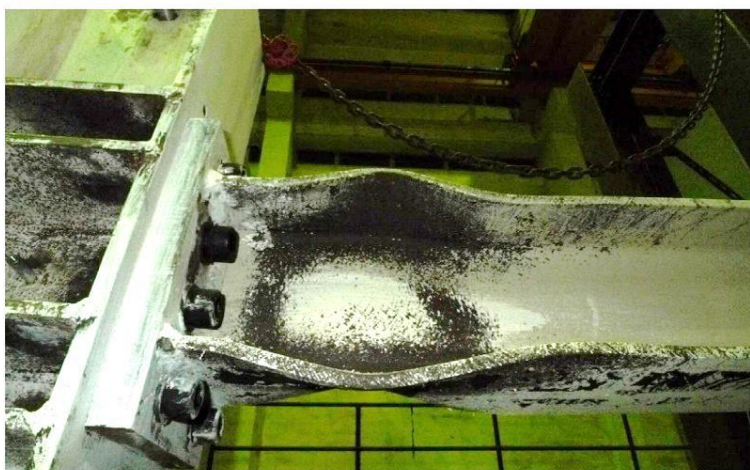
شکل ۱-۲۰- شکست تیر در محل اتصال با ستون در اثر بار چرخه‌ای [۲۶]
