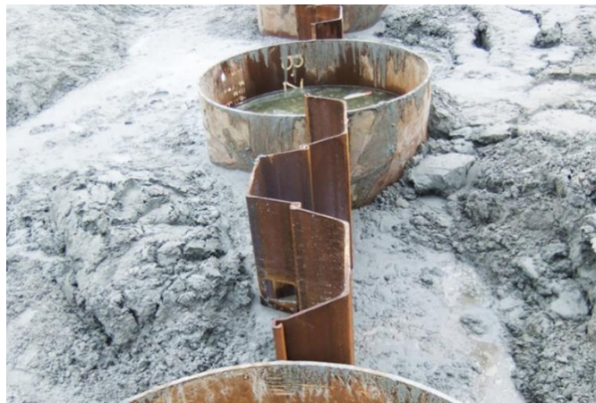
شکل (۲-۶) مقطع دیوار سپری مرکب
