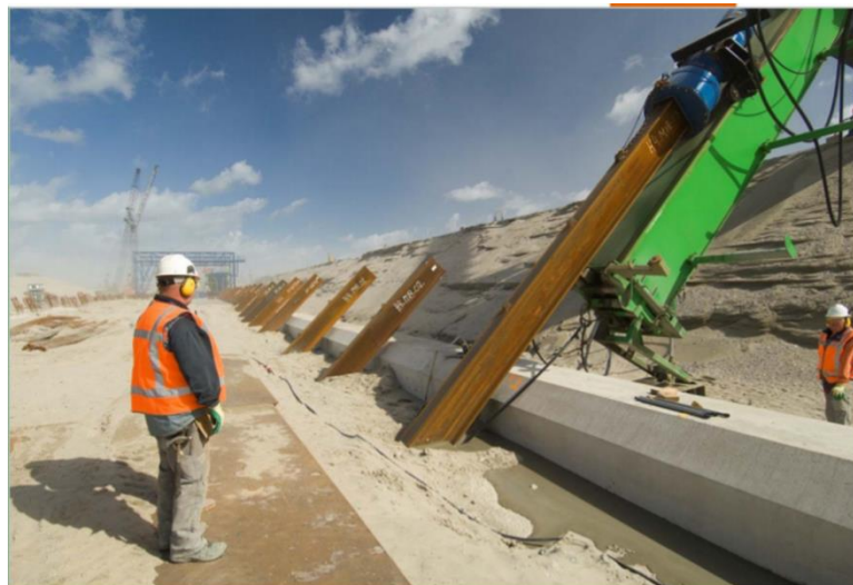
شکل (۸-۲) عملیات کوبش شمع m-v
