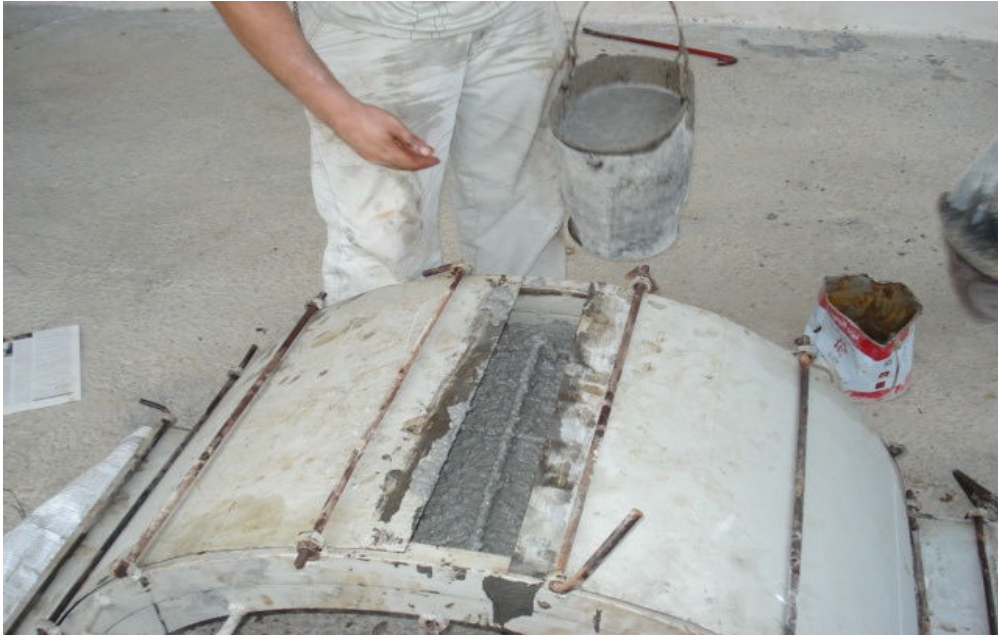
شکل ۳-۲۷ بتن ریزی قالب نهایی در کارگاه بابلسر
