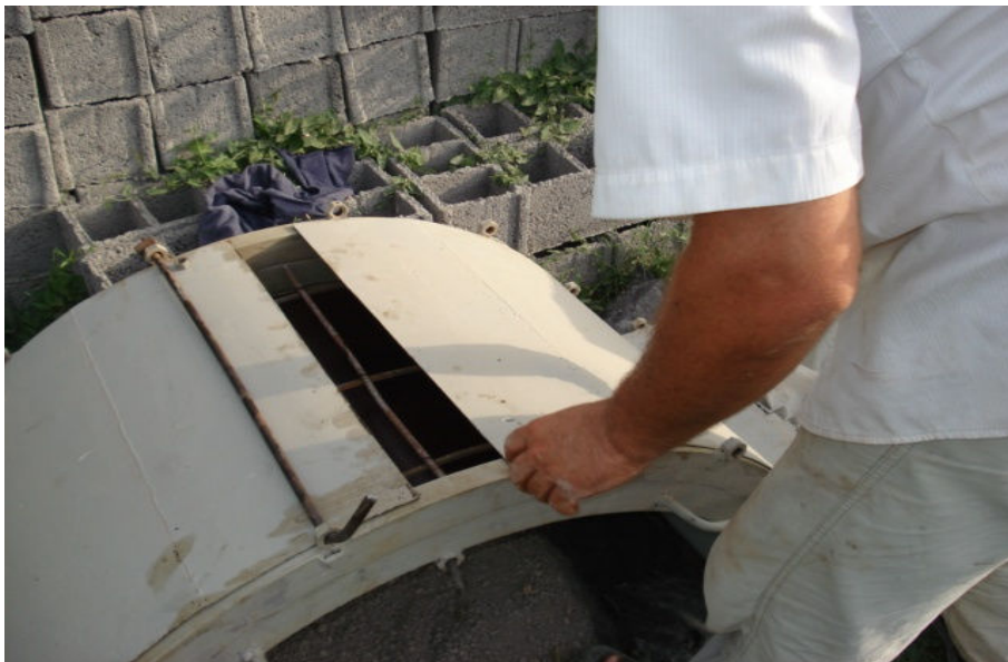
شکل ۳-۱۹ قالببندی تیرهای قوسی
