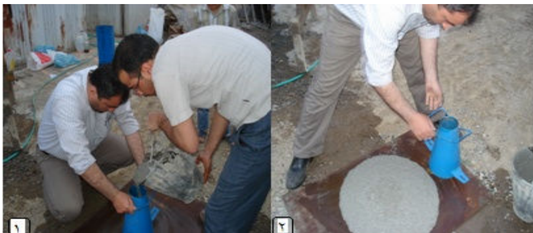
شکل ۳-۳ نحوه اجرای آزمایش اسلامپ در کارگاه بابلسر
