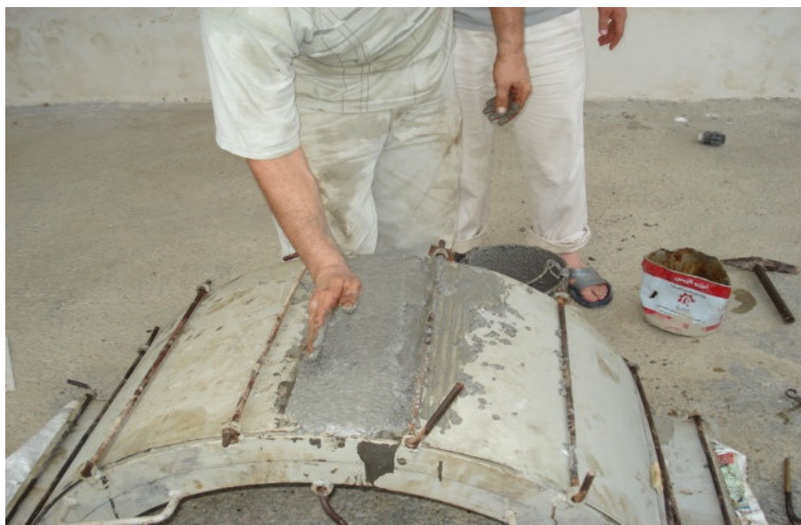
شکل ۳-۲۰ بتن‌ریزی تیرهای قوسی
