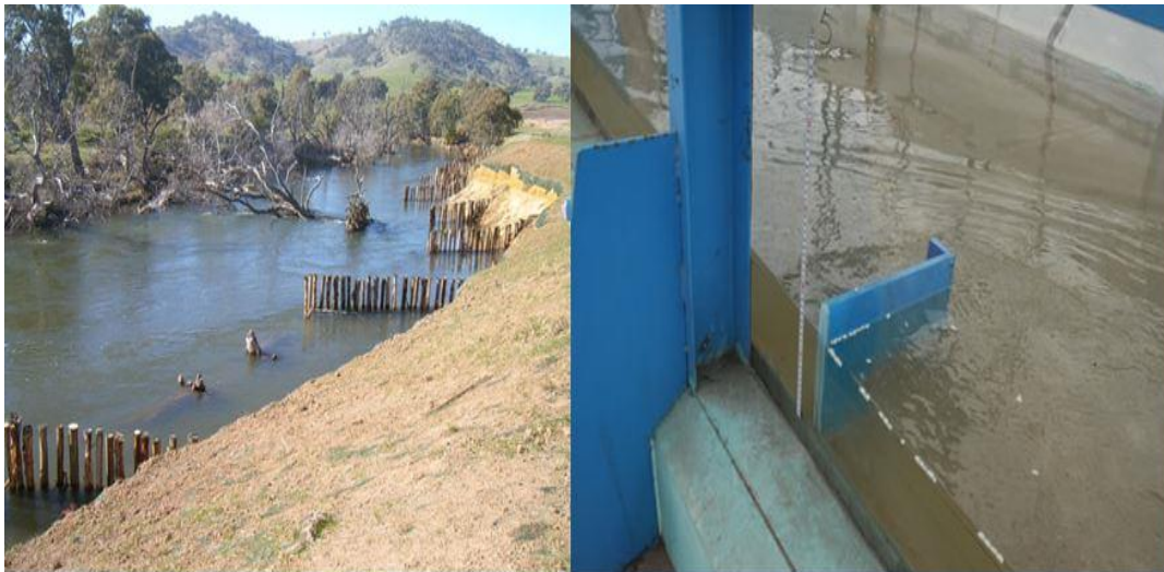
شکل (۱-۱) - نمای کلی سازه‌ی آبشکن
