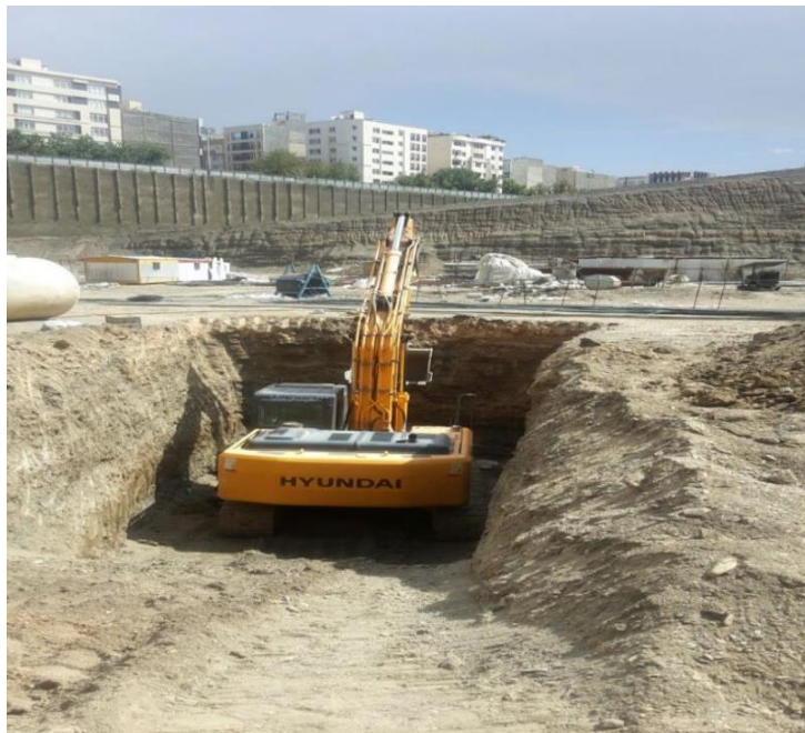
شکل ۵-۲۹- حفاری زمین جهت انجام آزمایش بارگذاری صفحه
