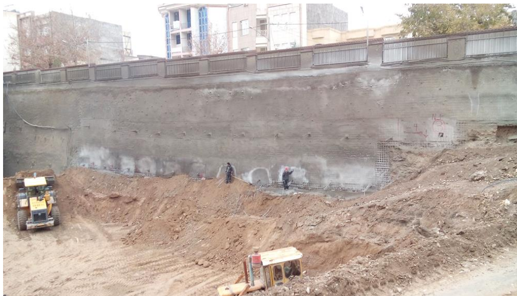
شکل ۲-۴- نمونه گود پایدار شده به روش مهاري و بلوک
