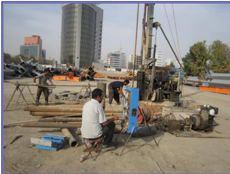
شکل ۳-۱- حفاری گمانه و انجام آزمایش صحرایی پرسیومتری در محل پروژه
