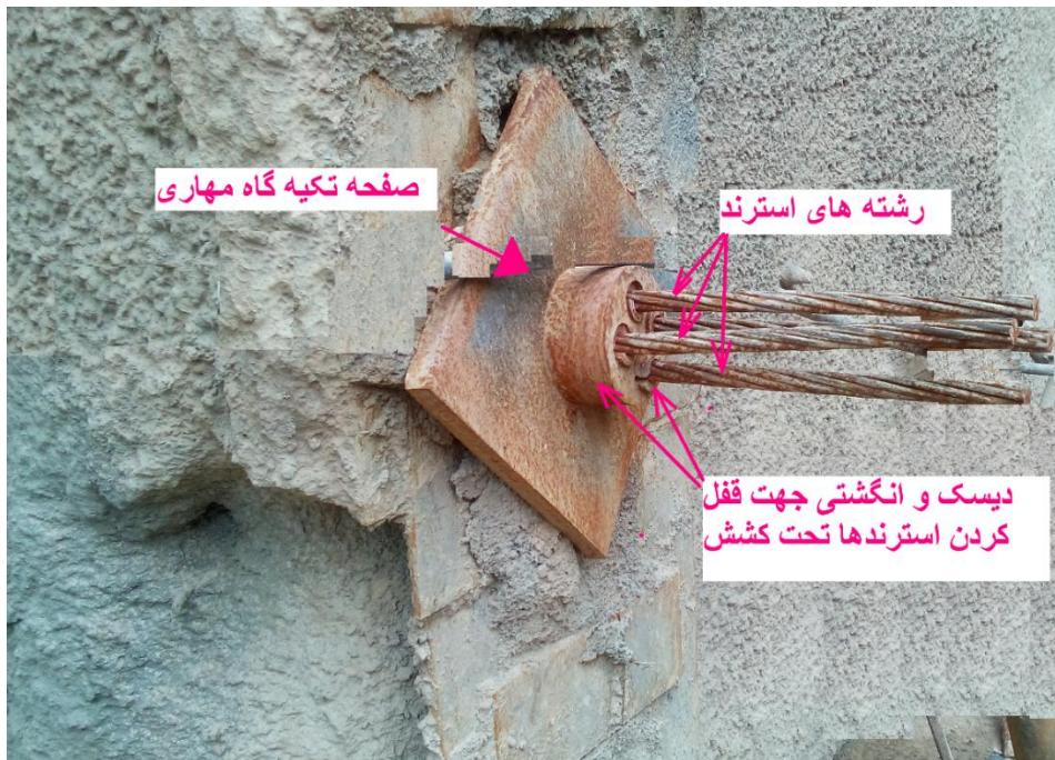
شکل ۲-۳- اجزای سر مهاری که توسط دیسک سوراخ دار و انگشتی تحت بار کشش قفل شده است.
