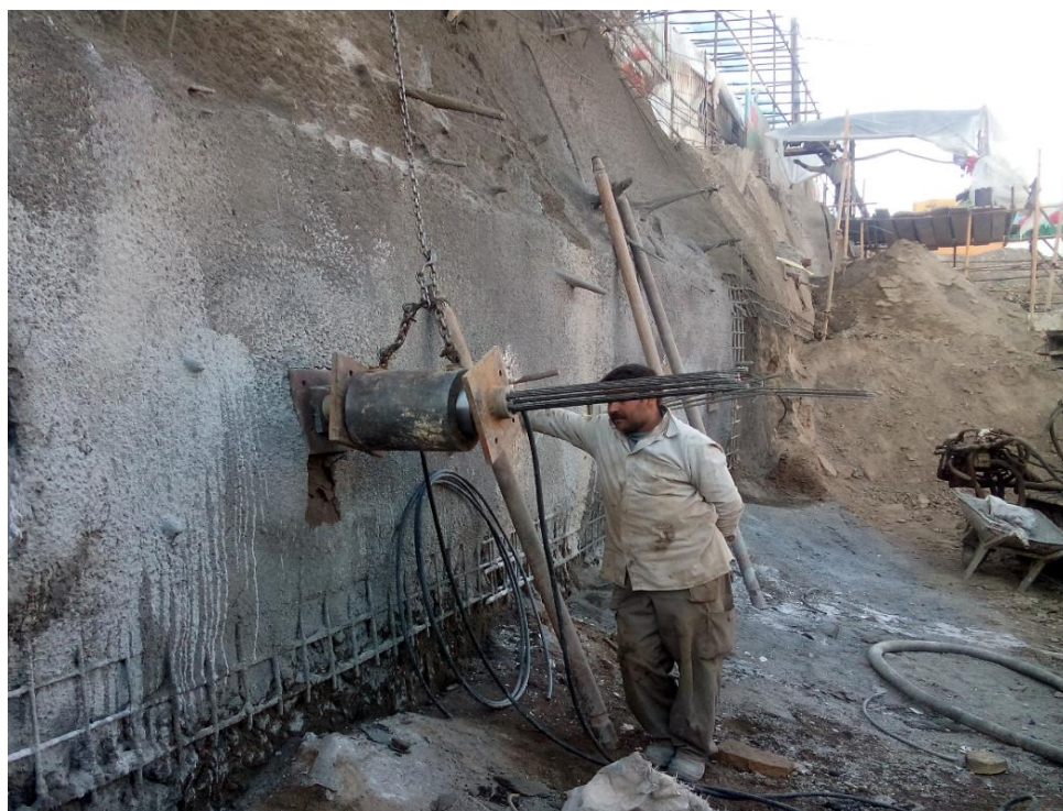
شکل ۲-۷- انجام عملیات کشش استرند توسط جک هیدرولیکی مخصوص
