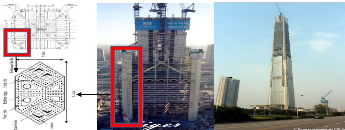
شکل (۲-۶۳): برج Tianjin Goldin 117 و Mega CFST به کار رفته در آن [۱۱۳]-Skyscraper
