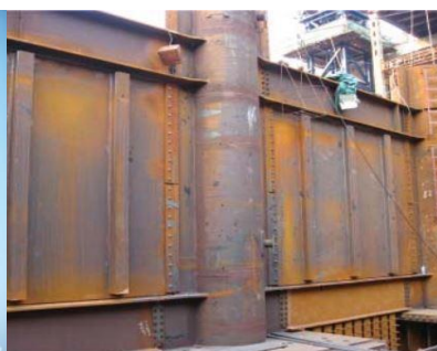
شکل (۲-۱۹): ستون CFST و دیوار برشی فولادی برج Jinta [۱۴]
