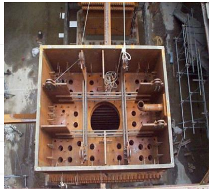
شکل (۲-۲۲): ابر ستون برج Taipei 101 CFST [۱۵]
