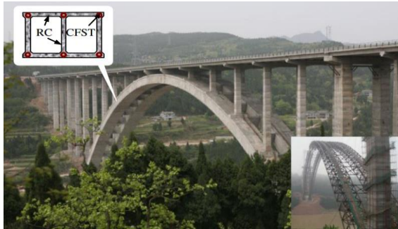
شکل (۲-۳۲): استفاده از عضو مرکب در پل سازی [۳]
