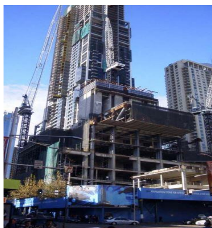
شکل (۲-۴۹): ساختمان در حال ساخت Latitude [۹۷]
