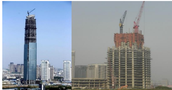
شکل (۲-۱۶): ستون‌های CFST در برج در حال ساخت Skyscraper-Google-Wuhan Center
