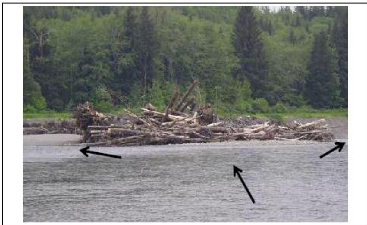
شکل ۲-۱۸b: نمونه ای از ELJ های تثبیت کننده رسوبات ساخته شده در سپتامبر ۲۰۰۴ در رودخانه Hoh، شرایط بعد از دو جریان حداکثری به ارتفاع تقریبی ۸۵۰ سانتیمتر در مارچ ۲۰۰۵ نمایش داده شده است.
