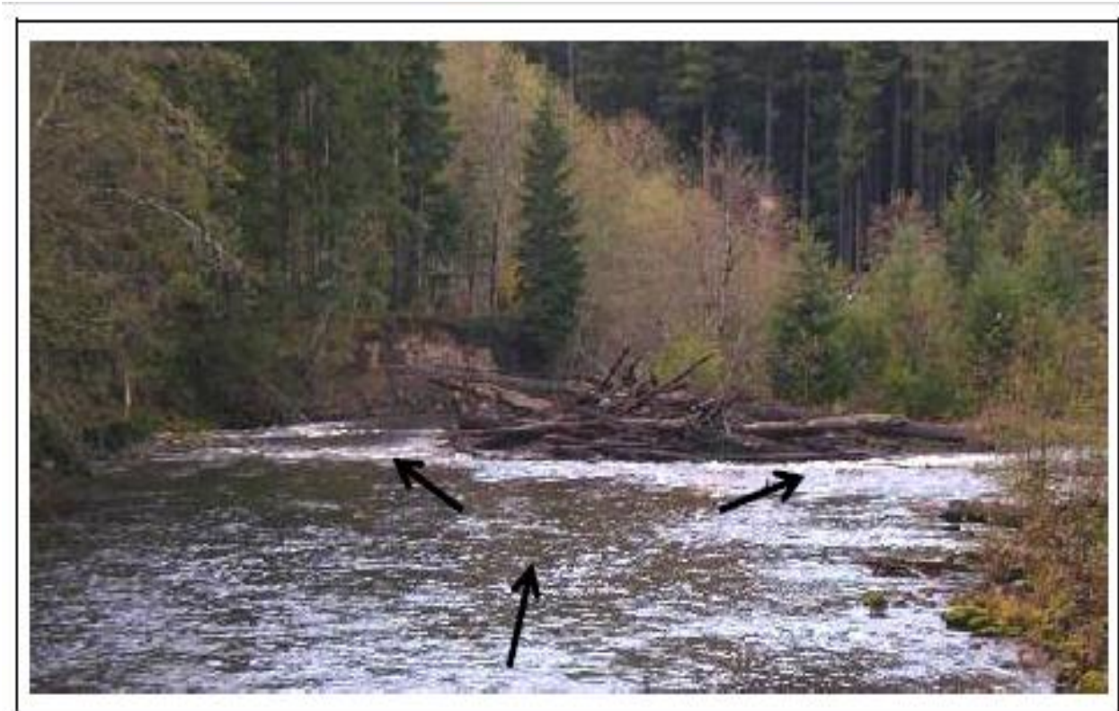
شکل ۲-۱۸a: نمونه ای از ELJ تثبیت کننده رسوبات طبیعی رودخانه Cispus.
