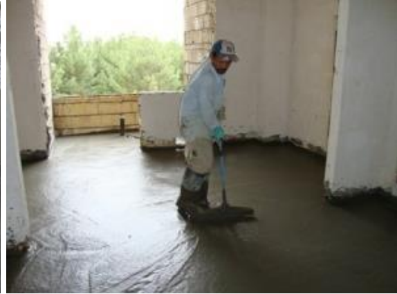
شکل ۳-۴- فوم بتن ریزی در کف طبقات برای تسطیح
