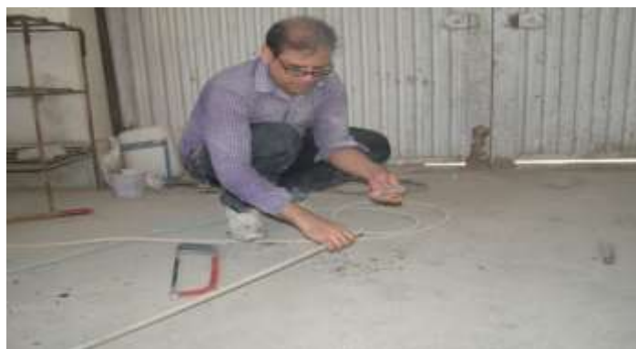
شکل ۳-۳ بریدن لوله پلیکا برای تنظیم کردن طول پیوستگی
