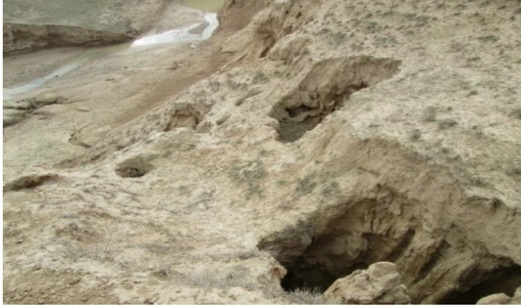
شکل ۱-۳ پدیده فروریزش در خاک منطقه (نوکنده، ۱۳۹۴)
