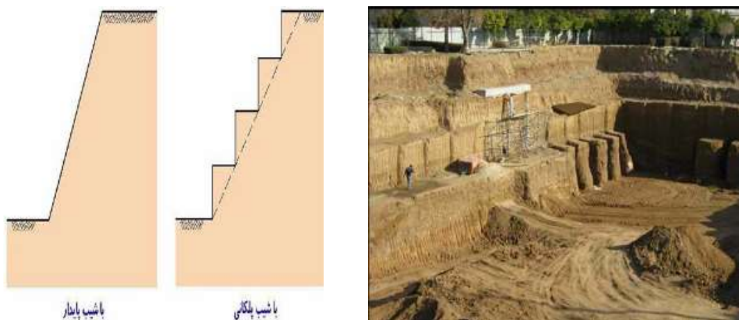
شکل ۲-۴۶ مهاربندی به روش شیبدار کردن
