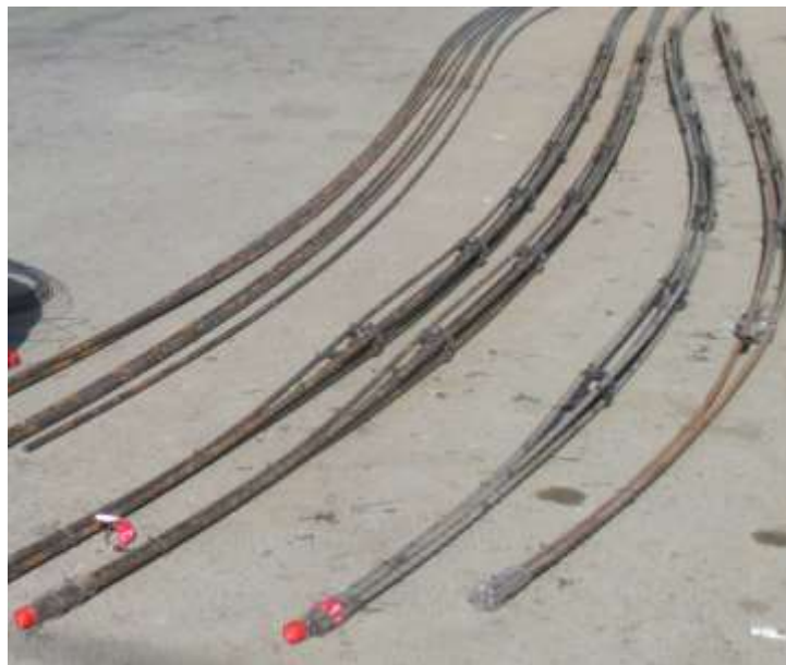
شکل ۲-۳۸ نمایش نحوه مونتاژ دسته استرندها
