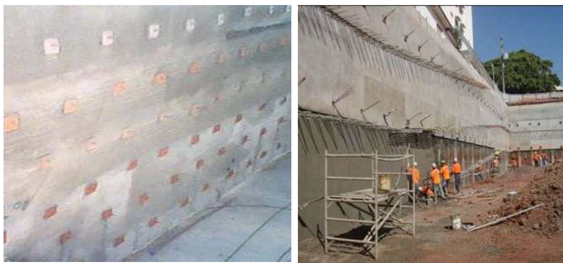
شکل ۹-۲ جداره های مهاربندی شده توسط نیلینگ
