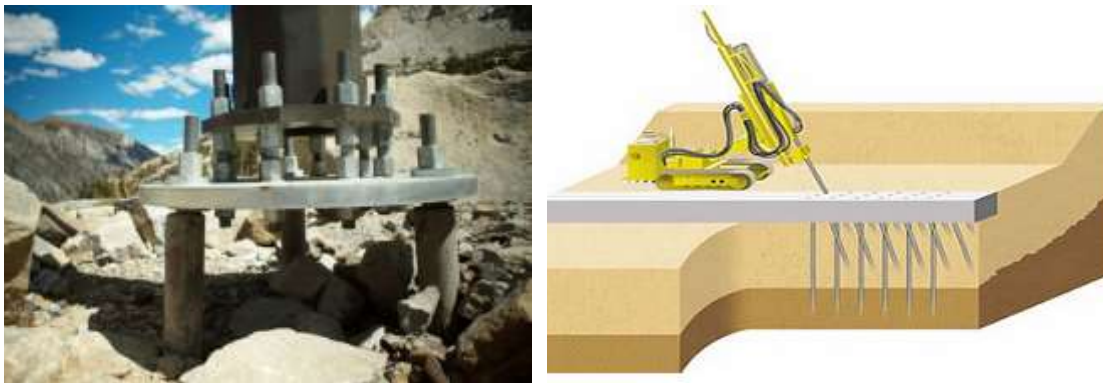
شکل ۲-۴۴ مهاربندی به روش میکروپایل
