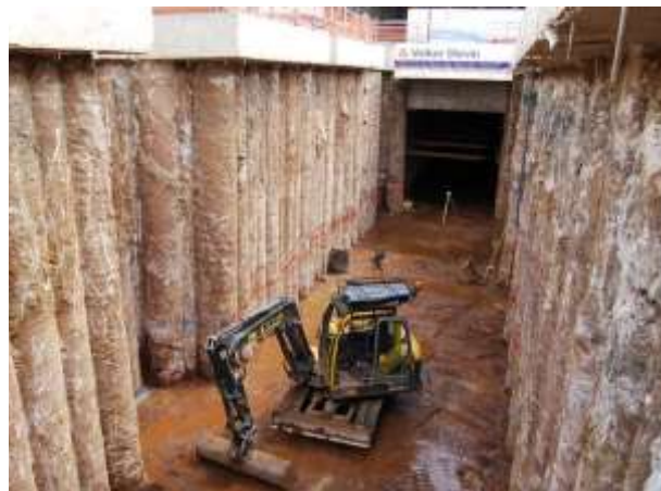
شکل ۲-۶ مهاربندی توسط شمع‌های درجا
