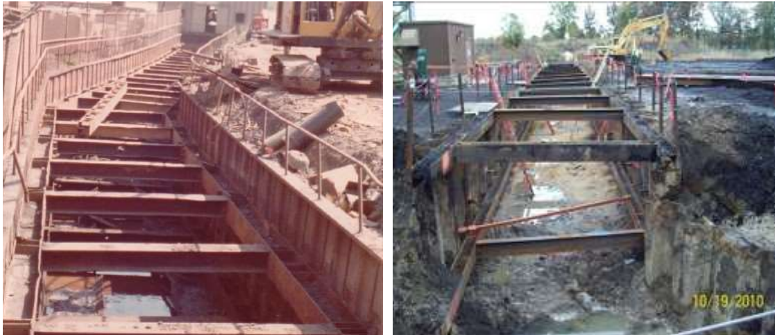
شکل ۲-۳ مهاربندی جداره ها توسط المان های افقی و مایل
