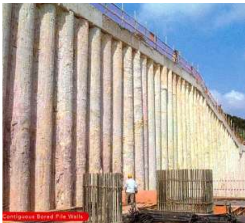
شکل ۲-۶ مهاربندی توسط شمع‌های درجا
