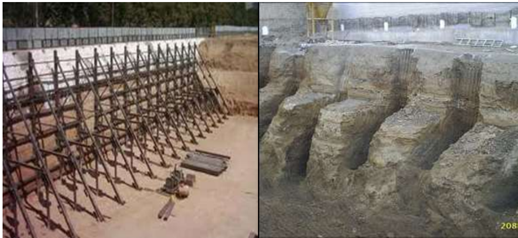
شکل ۲-۴۵ مهاربندی توسط سیستم خرپایی
