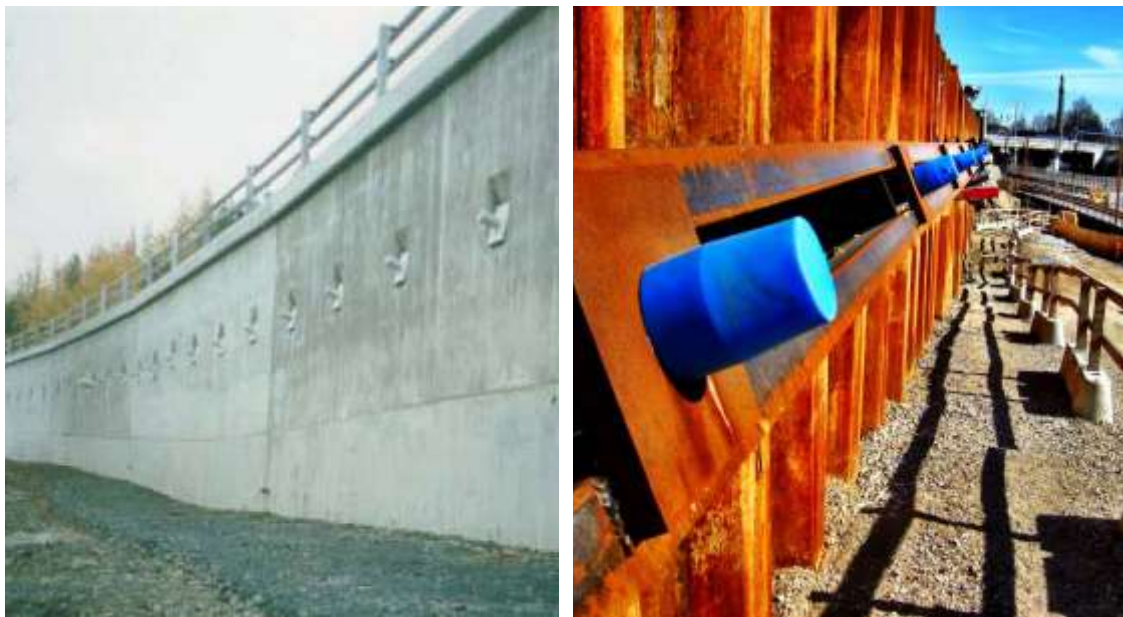
شکل ۲-۲۶ مهاربندی به روش انکراژ
