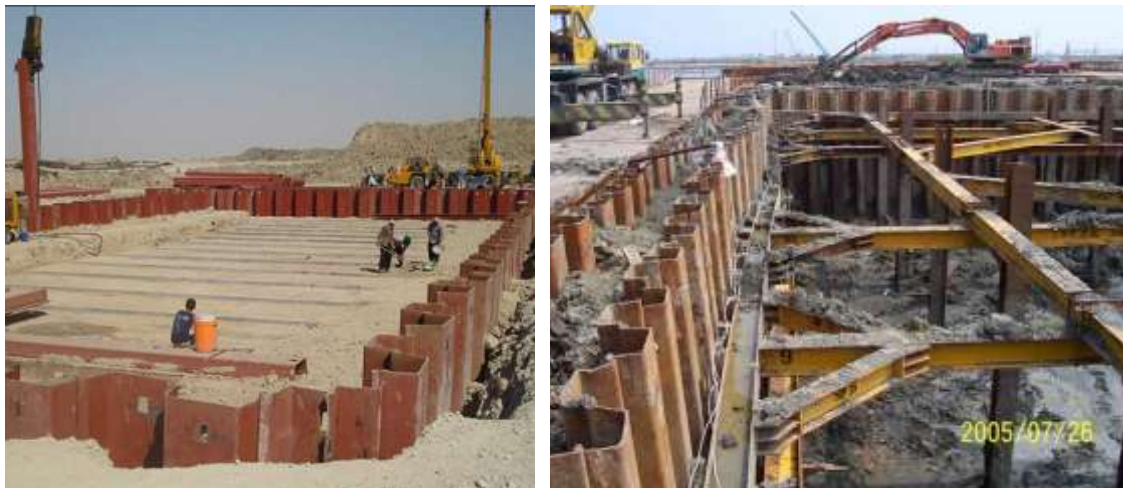
شکل ۲-۵ مهار بندی به روش Sheet pile
