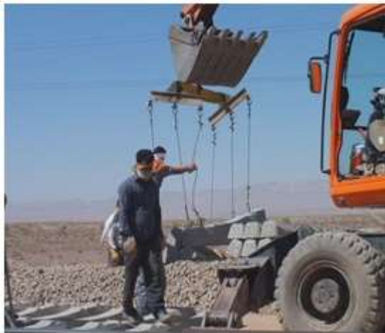
شکل (۴۷-۳) نصب تراورزها
