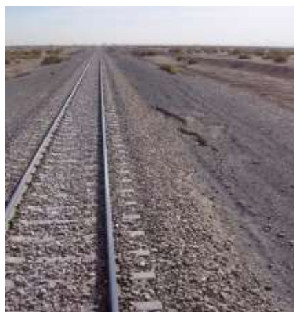
شکل (۳۵-۳) شکاف‌ها در پایین دست و موازی مسیر
