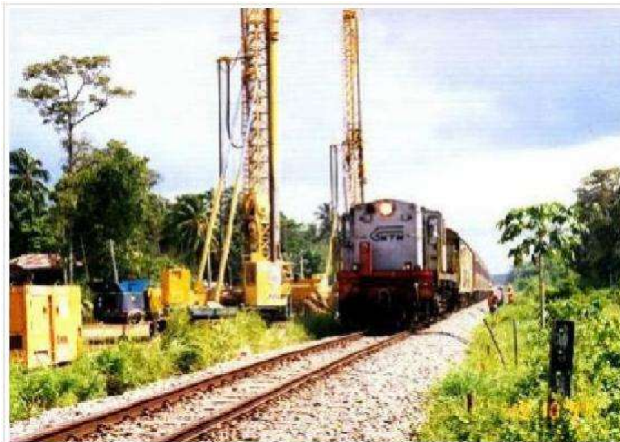
شکل (۲-۴۷) عملیات جایگزینی ارتعاشی در طول خط راه‌آهن KTM در Gurun برای کارخانه کود سازی Petronas Kedah
