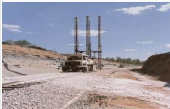
شکل (۴۰-۲) نمونه عکس نشان دهنده اجرای تزریق دوغاب خاکستر سرباره/آهک
