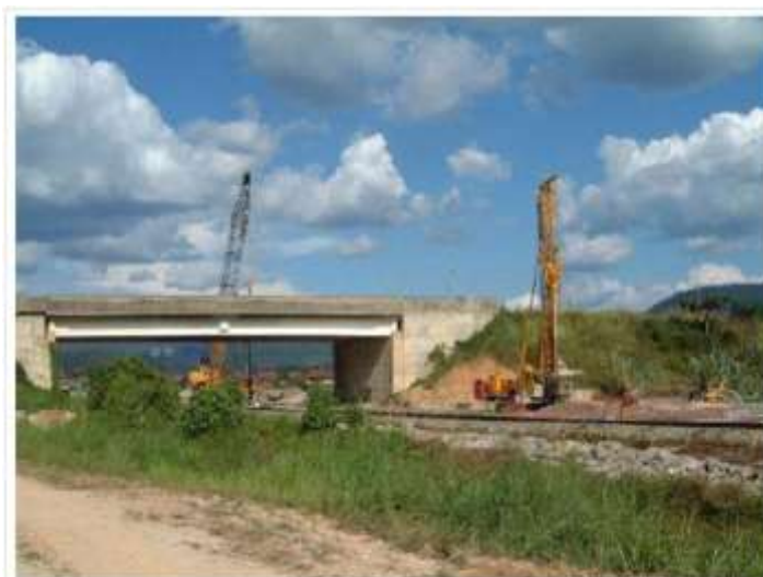
شکل (۲-۵۳) تصویر عملیات جایگزینی ارتعاشی به منظور اتصال مسیر موجود
