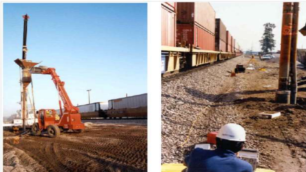
شکل (۲-۳۸) عملیات نصب و نگهداری در محل
