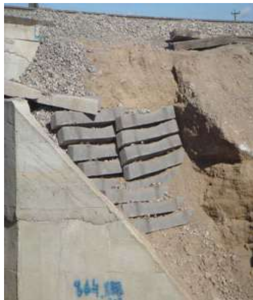
شکل (۳-۳۰) وضعیت نامناسب زیرسازی در خاکریز قبل از پل ابریشم
