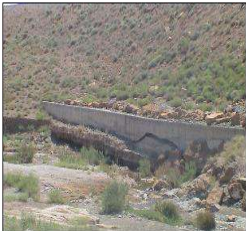
شکل (۳-۲۹) آسیب دیدگی دیوار هدایت آب مربوط به پل ۴ نشست متری که مسیر راه آهن را قطع کرده و ادامه آن تا چند صد متر میرسد
