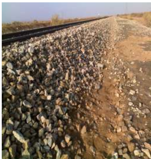
شکل (۲۱-۳) نشست کنار خط و پای خاکریز در محدوده کیلومتر ۷۲۷ الی ۷۲۹
