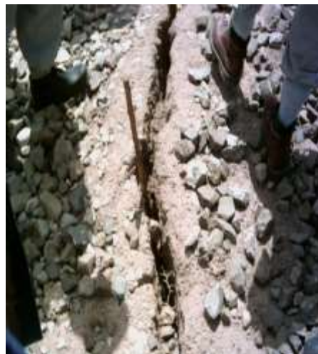
شکل (۳-۱۶) ترکهای طولانی در خاکریز خط شکل در کیلومتر ۲۷۷+۵۰۰ واقع در بلاک سمنان - میان دره
