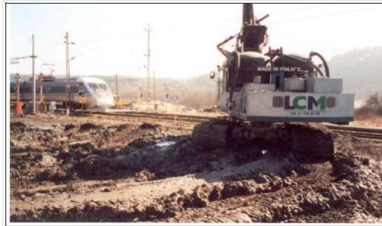
شکل (۳۶-۲) نصب ستون‌های سیمان-آهک برای تثبیت خاک مجاور مسیر راه آهن
