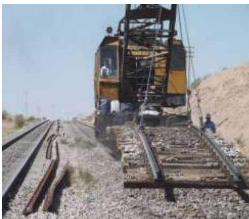
شکل (۴۳-۳) استفاده از تجهیزات آلمانی و متراکم کردن
