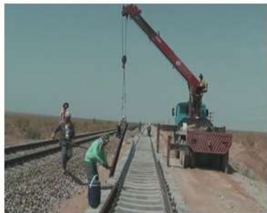
شکل (۴۸-۳) نصب ریل
