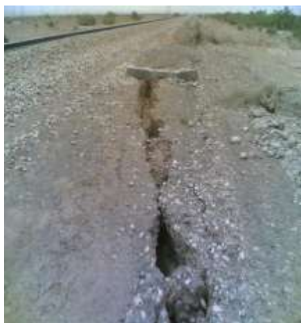
شکل (۳۳-۳) محدوده اطراف خط آهن و شرایط ترک‌های کنار آن
