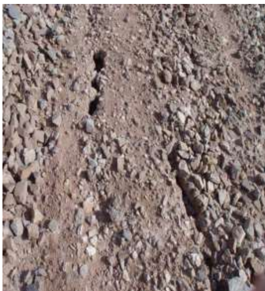
شکل (۳-۱۵) نشست و رانش زیرسازی خط در بلاک زوال ریزی آن در بلاک میاندره سمنان
