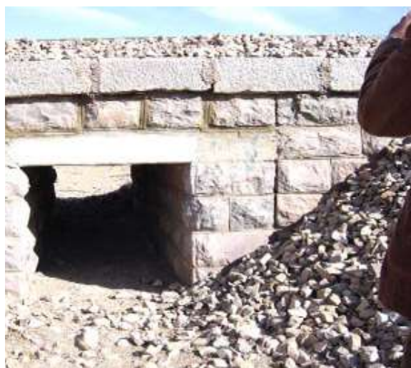
شکل (۳۷-۳) وضعیت آبرو در محل وجود ترک در کنار خط
