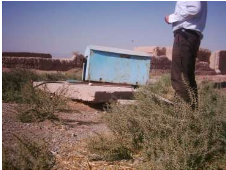
شکل (۳-۱۳) کج شدگی و شکست بلوک سیمانی جدار چاه (حومه روستای بکران)
