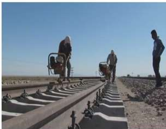
شکل (۴۹-۳) بستن پیچ پایند
