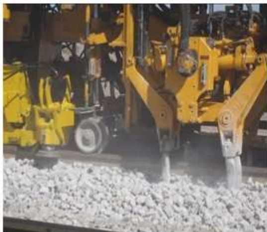
شکل (۳-۵۱) کوبیدن بالاست
