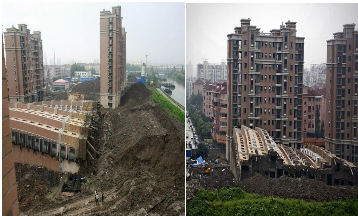
شکل ۲-۱ نمونه ای از تخریب شالوده عمیق در اثر نیروی زلزله
