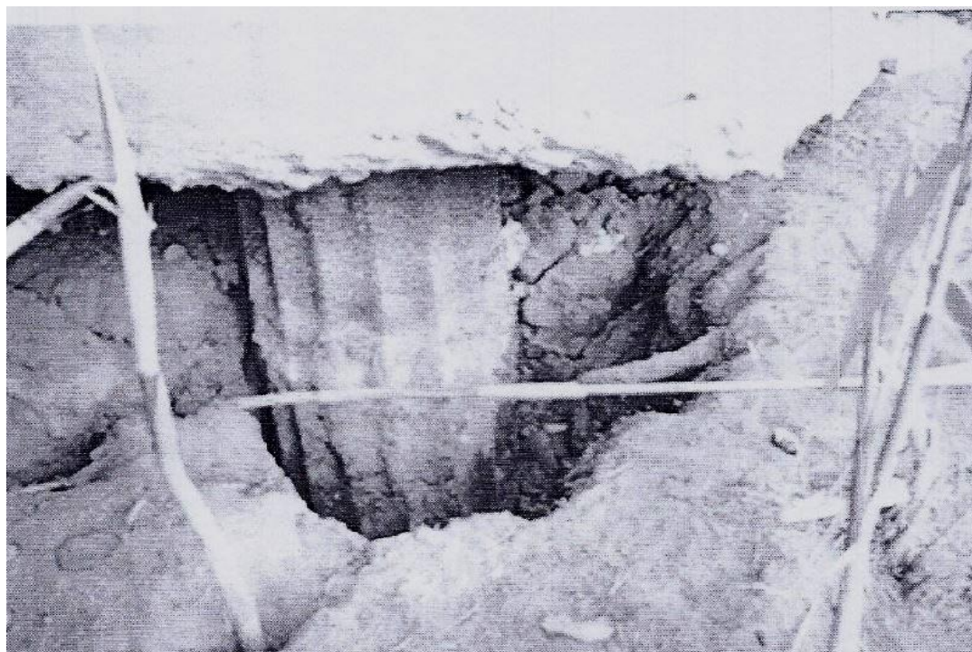
شکل ۳-۱ ایجاد شکاف بین بدنه شمع و خاک
