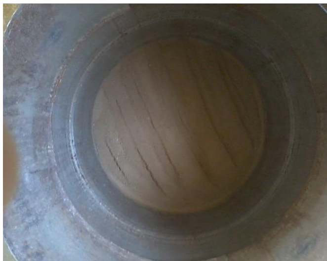
شکل ۳-۴ شیار زدن سطح هر لایه بعد از کوبش قبل از ریختن لایه بعدی
