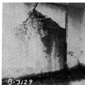
پ- گسستگی دیواره پایه پل به واسطه انبساط روسازی
