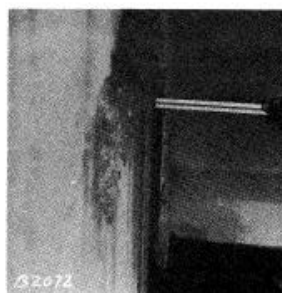
ب- درز انبساط بسته شده بین دالهای عملکردی روسازی و پل
