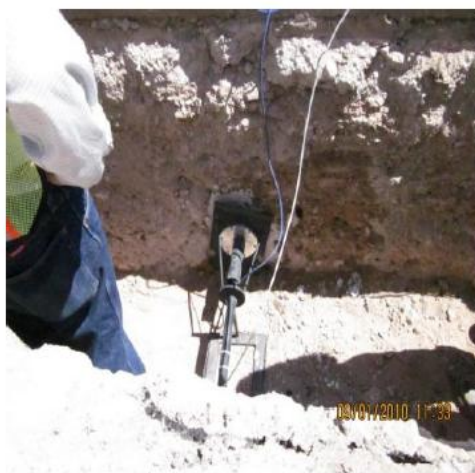
شکل ۲-۲۱ نصب سلول فشاری مونتاژ شده با جک (Jaiswal, et al., 2012)
