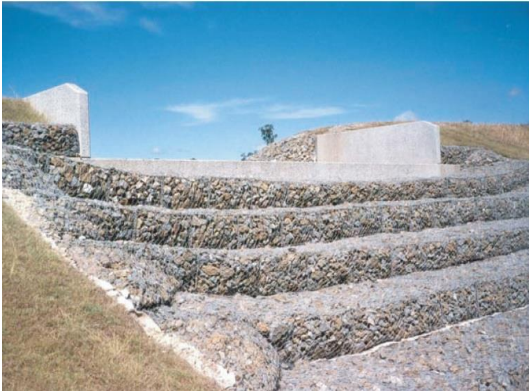
شکل (۱-۲): نمایی از سرریز پلکانی گابیونی سد رابینا ۲ در استرالیا [۲]
