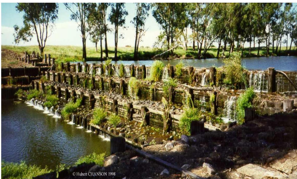
شکل (۲-۳): نمایی از یک سدپلکانی الواری در استرالیا [۸]
