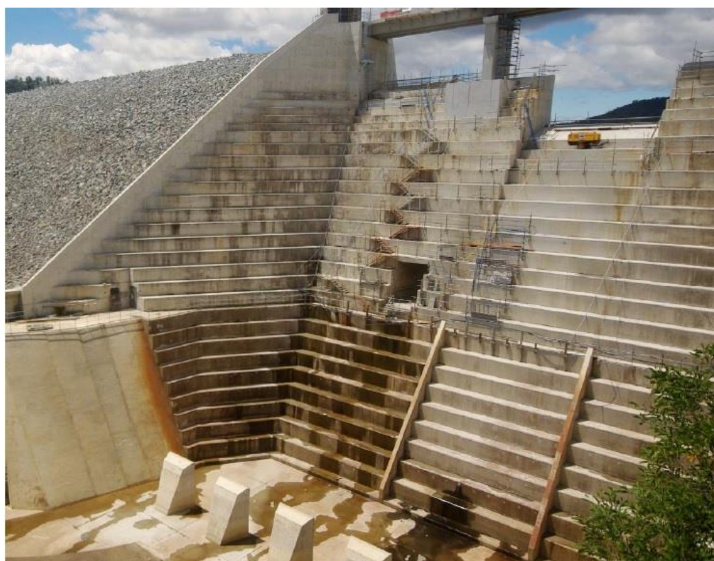
شکل (۱-۱): نمایی از سرریز پلکانی سد هینز ۱ در استرالیا [۱]
