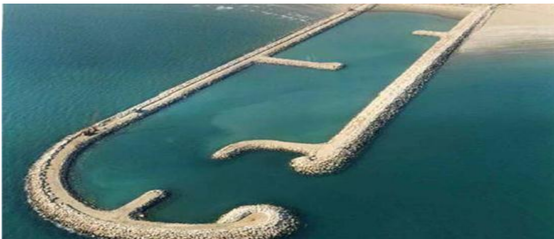
موجشکن آب شیرین کن کنارک در خلیج چابهار به طول تقریبی ۲/۱ کیلومتر و عمق ۵/۲ تا ۶ متر
