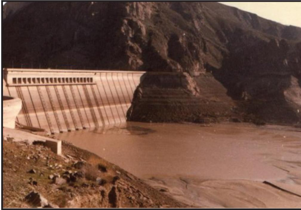
شکل ۱-۲: نمایی از بالادست سد سفیدرود که انباشته شده از رسوب (نشریه شماره ۵۸۹، ۱۳۹۱)
