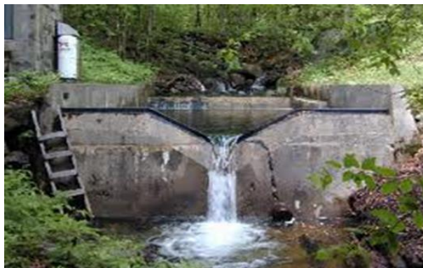
شکل (۱-۱) نمونه‌هایی از سرریزهای نرمال مثلثی و مستطیلی
