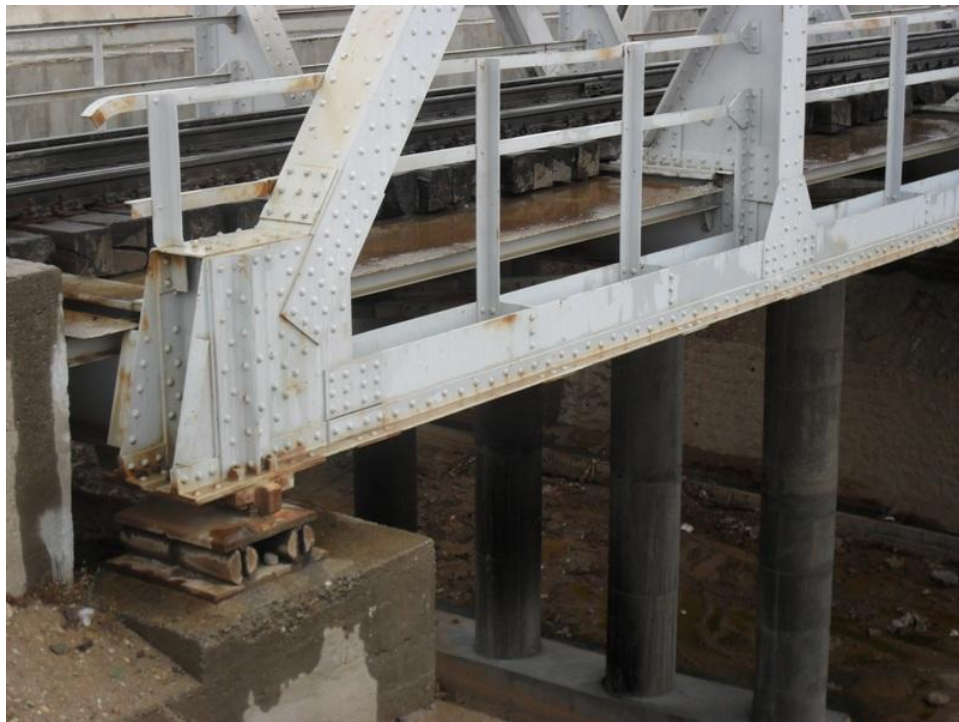
شکل (۱۱-۴) نمایی از تکیه‌گاه غلتکی پل
