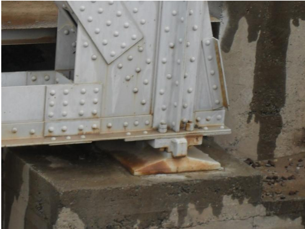
شکل (۴-۱۲) نمایی از تکیه‌گاه مفصلی پل
