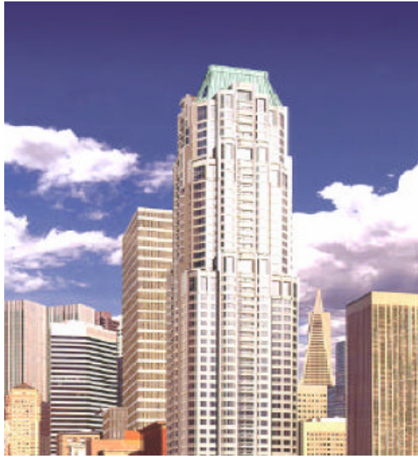
شکل (۲-۹) ساختمان مسکونی ۵۱ طبقه واقع در سان فرانسیسکو ( کالیفرنیا )
