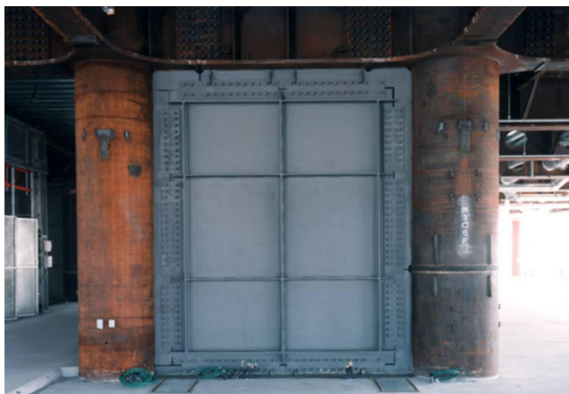
شکل (۴-۲) دیوار برشی فولادی تقویت شده در ساختمان ۲۰ طبقه نیپون استیل در توکیو ژاپن
