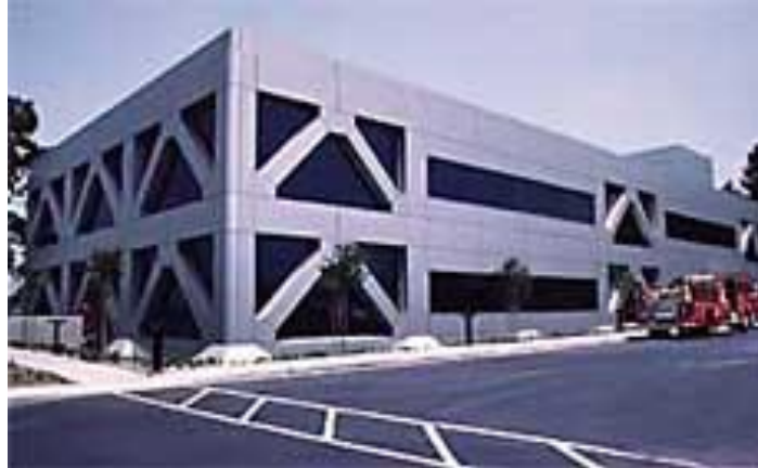
شکل ( ۲-۵ ) : مرکز آتش نشانی و کنترل حریق لس آنجلس
