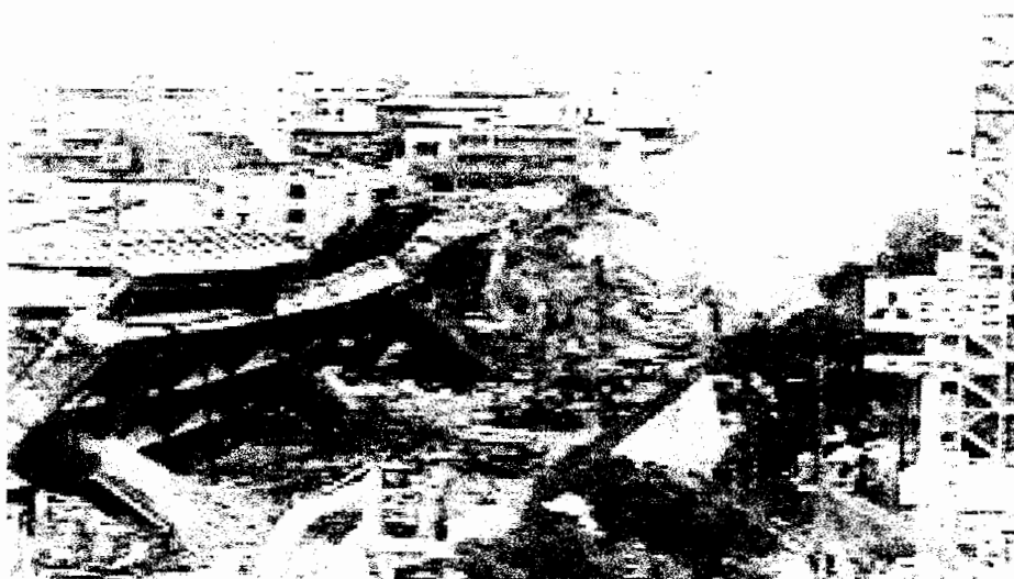
شکل ۳-۴- فرو ریزش تمامی ۱۷ قاب از پل Fukae ژاپن در زمین لرزه Hyogoken-Nanbu به علت تشدید ناشی از نزدیکی به گسل و ایجاد تغییر شکلهای بزرگ
