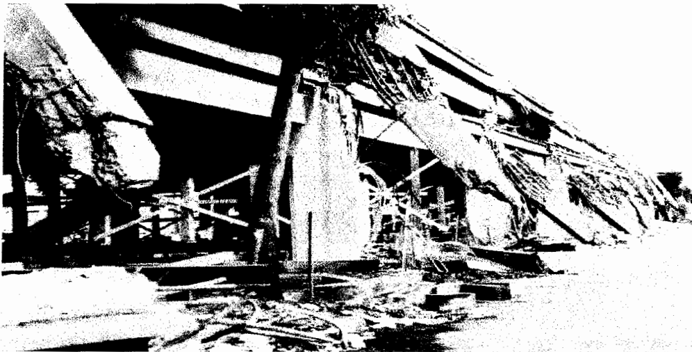
شکل ۳-۱۵- فروریزش فاجعه آمیز پل Cypress در زلزله Loma Prieta
