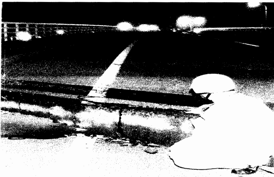
شکل ۳-۵- ضربه زدن روسازه و کوله و آسیب وارده به کوله در کوبه ژاپن
