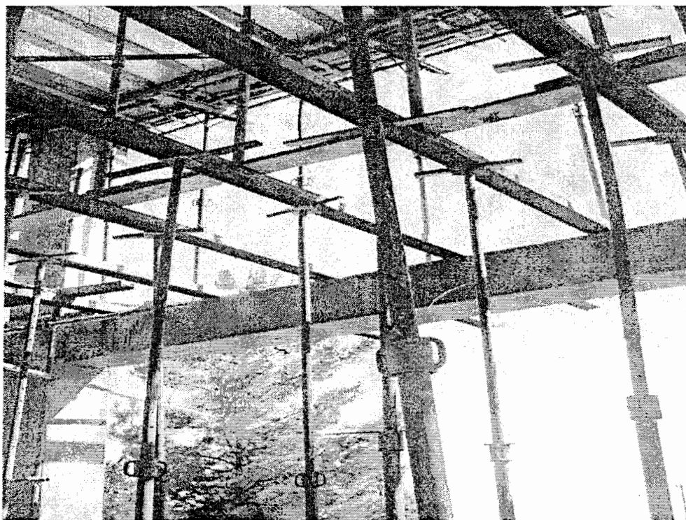
شکل پ-۱۸ : نحوه نامناسب انتقال بار شمع ها به عناصر سازه ای
