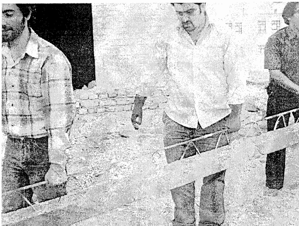
شکل پ-۲۳: تصویری از حمل تیرچه ها به محل استخراج به منظور عمل آوری
