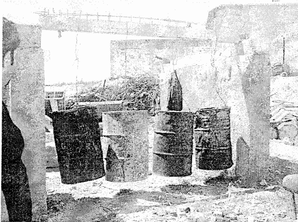
شکل پ-۷: نمای جانبی از بارگذاری تیرچه ۳ متری
