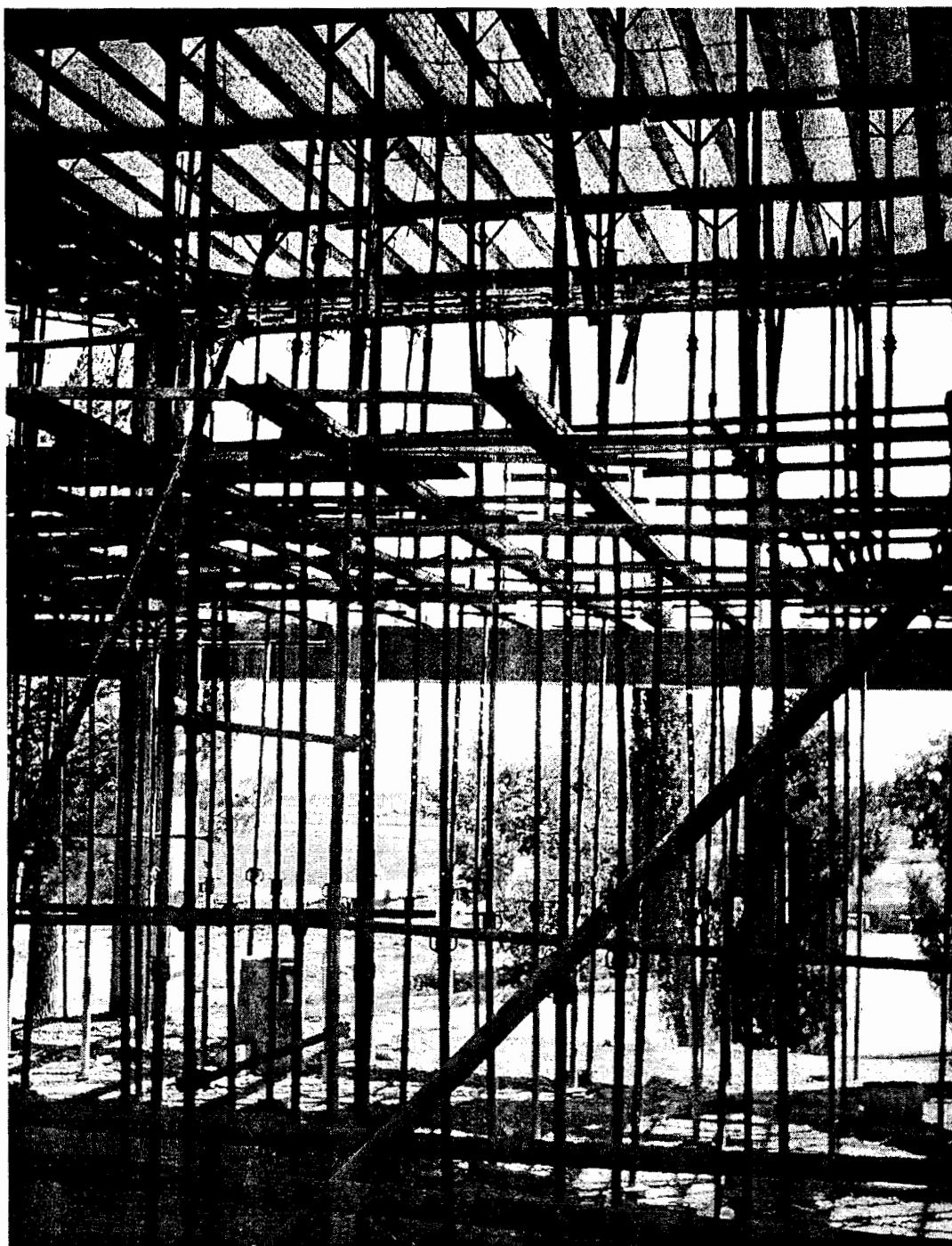
شکل (۹-۱) اجرای سقف در تراز ۹/۵ متر بالاتر از سقف طبقه پایین
