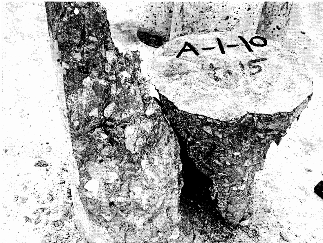
ت ۱۱- گسیختگی مخروطی برشی
