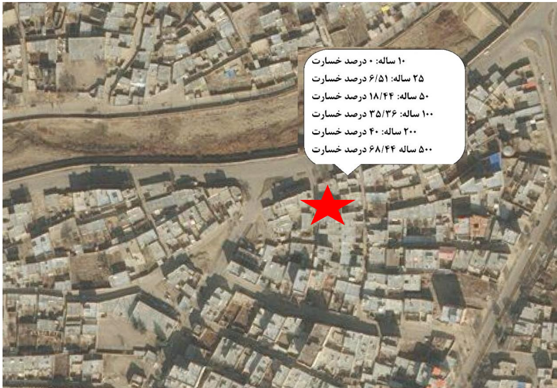
شکل (۴-۳۰): برآورد درصد خسارت وارد شده ساختمان مسکونی
