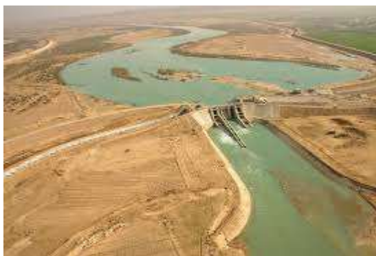
شکل ۱-۲ - نمایی از یک سد انحرافی
