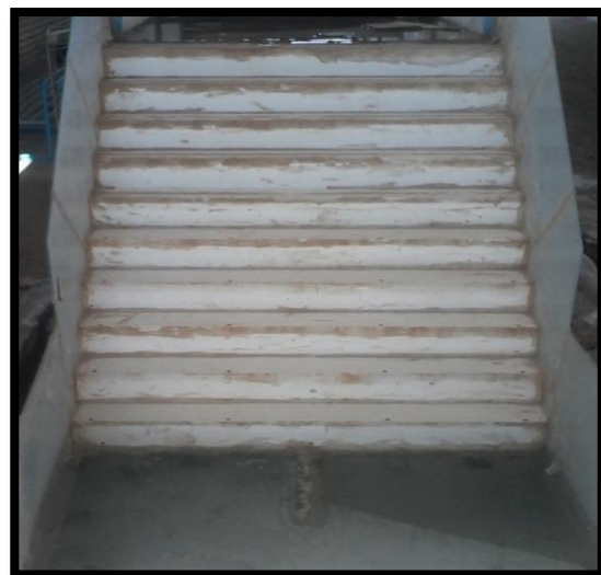
شکل ۳-۳- نمایی از سرریز پلکانی ( بعد از نصب)
