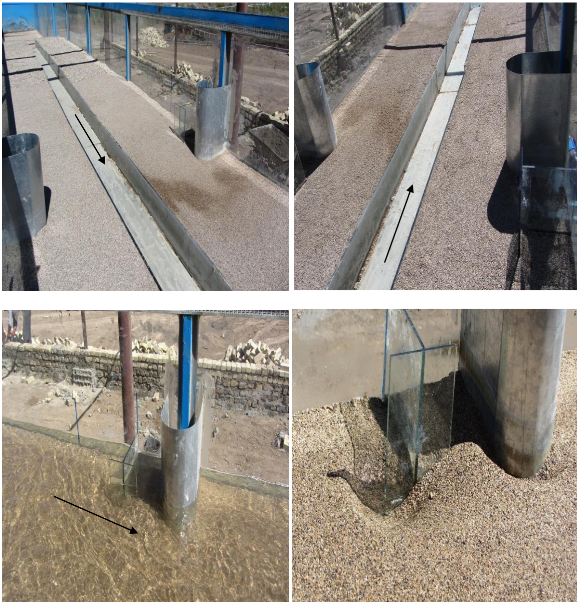
شکل ۳-۴- نمای از آبشکن و تکیه‌گاه T شکل
