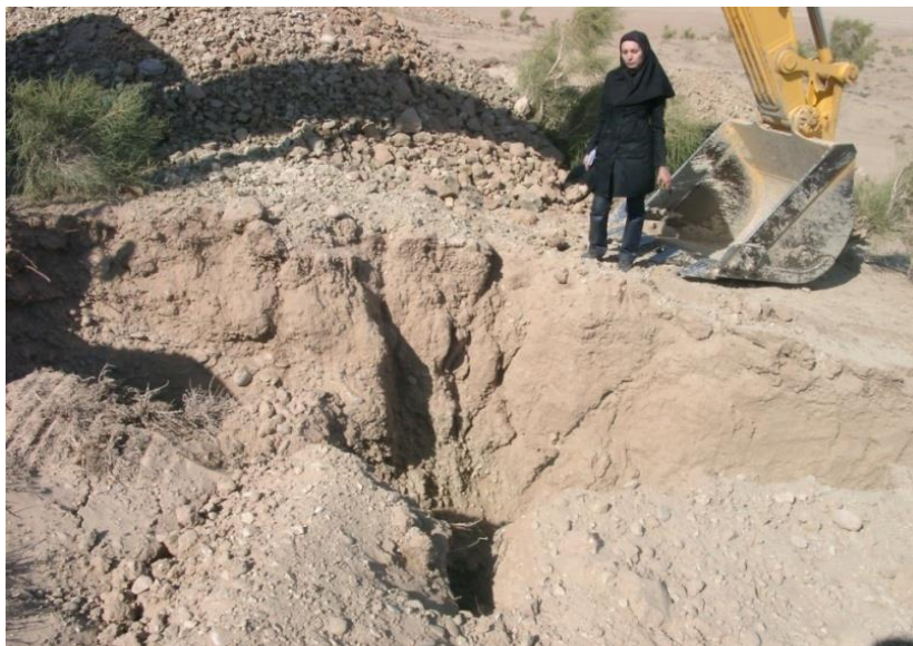
شکل ۵-۶: حفر ترانشه عمود بر گسیختگی
