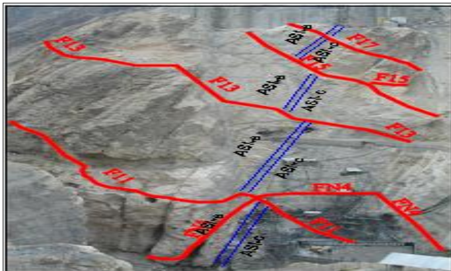
شکل ۱-۶- موقعیت بعضی از شکستگی‌های مهم در تکیه‌گاه راست سد (مه‌اب قدس، ۱۳۹۱)
