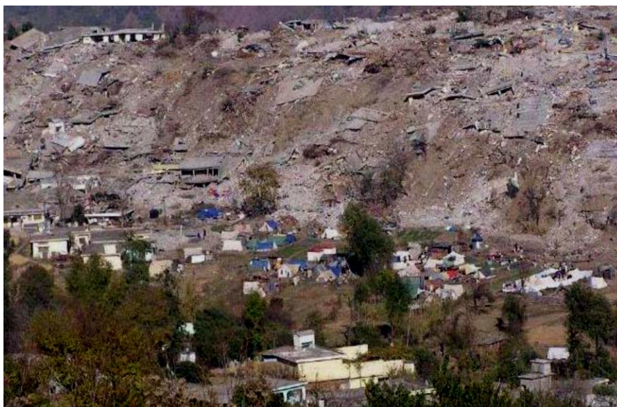
شکل ۳-۵- تخریب بیشتر ساختمان‌های واقع در بالای تپه نسبت به ساختمان‌های پای تپه در زمین لرزه ۸ اکتبر ۲۰۰۵ بلاکوت پاکستان به دلیل تاثیر توپوگرافی در تشدید امواج زلزله (Shafique, 2008).
