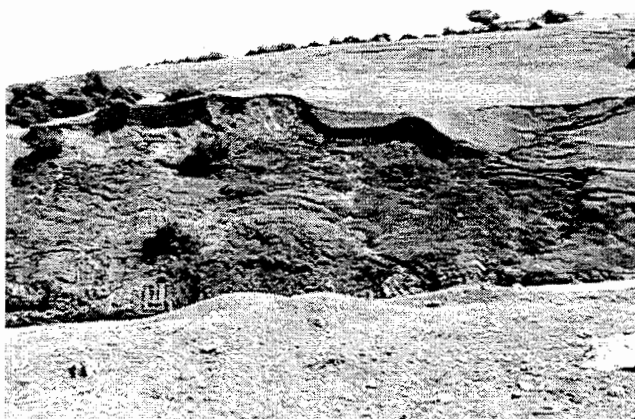
شکل ۳-۷: لغزش دورانی نزدیک روستای وری در اثر احداث ترانشه
