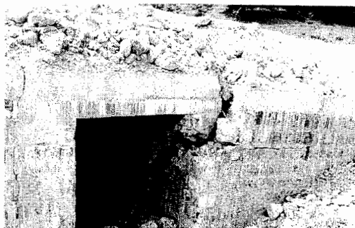
شکل ۳-۶: تخریب پل درینجه دامنه لغزشی
