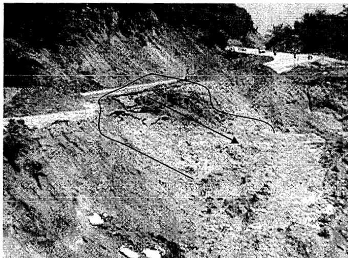
شکل ۳-۱۳ : وقوع لغزش در اثر انباشته شدن خاکریزهای قبلی
