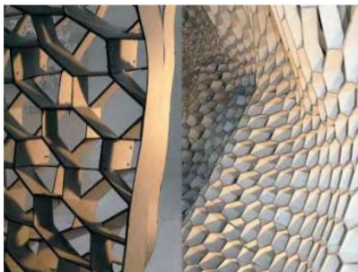
شکل 2-7- نمونه لانه زنبوری الگوریتمی که در آن هر سلول در شکل اندازه و عمق برای پاسخگویی به تراکم و بازشدگی منحصر به فرد است- منبع مجله AD، 2006، جلد 76
