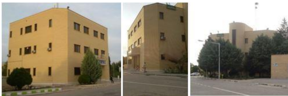
شکل ۳-۸. تصاویری از ساختمان مرکز کامپیوتر، ماخذ: نگارنده.
